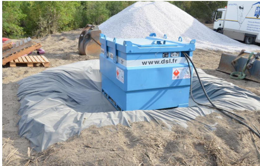
☞ Photographie 21 : Mise en place d'une aire étanche autour d'un groupe électrogène
