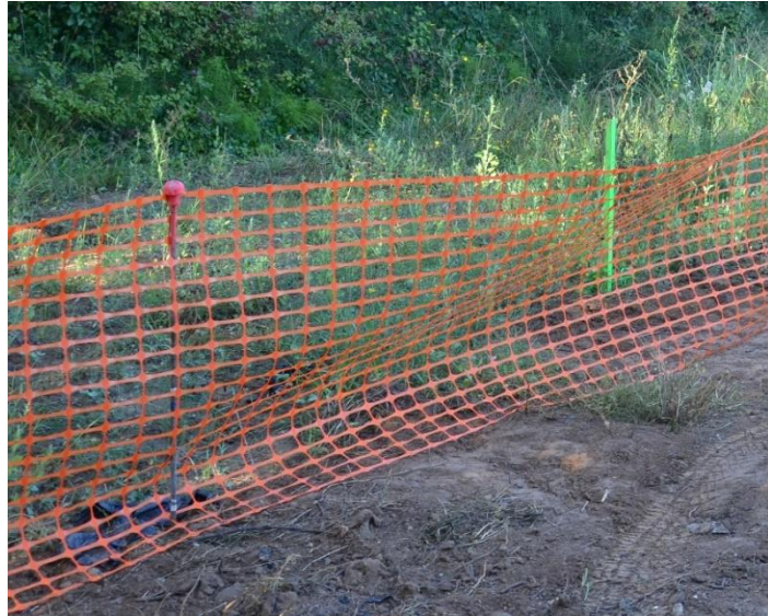
☞ Photographie 17 : Dispositif de limitation des emprises des travaux
