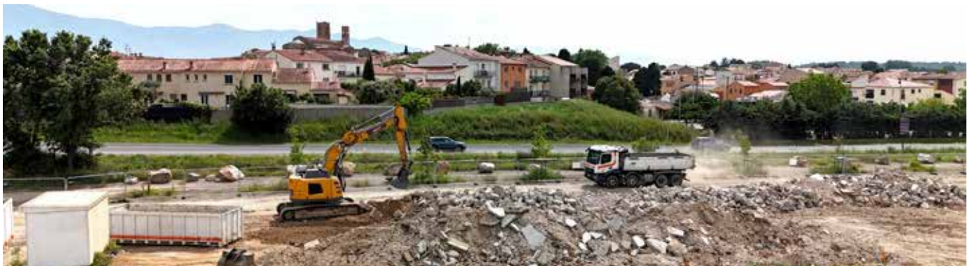
Démolition des boxes du marché de gros.
