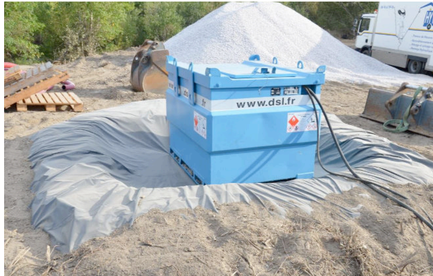
☞ Photographie 1 : Mise en place d'une aire étanche autour d'un groupe électrogène
