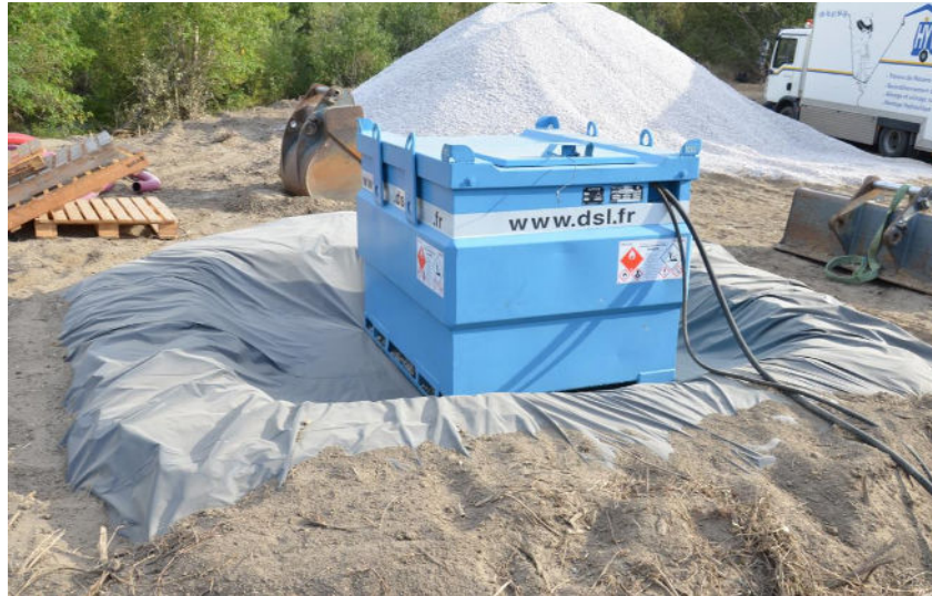
☞ Photographie 18 : Mise en place d'une aire étanche autour d'un groupe électrogène
